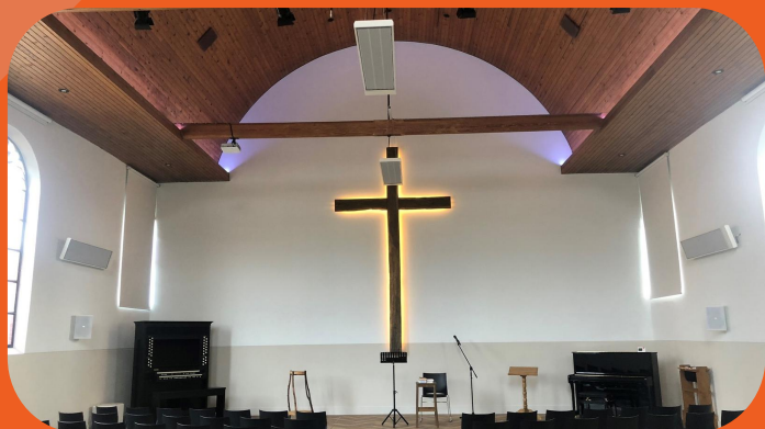
NGK De Ontmoeting - Voorthuizen Elektrische donkerstralers
